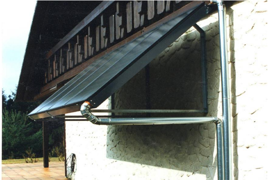
Ein an der südorientierten Giebelwand montierte Flachkollektoranlage. Eine Lösung für Bestandswohngebäude, bei denen die Dachfirste leider vorwiegend in Nord-Südrichtung orientiert sind.
