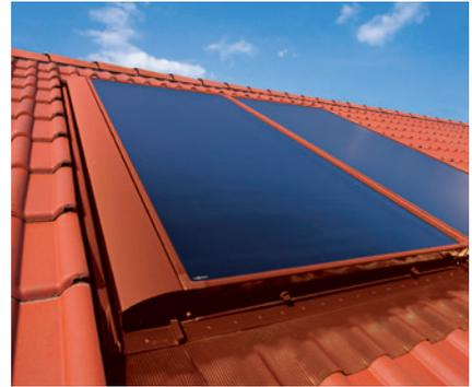
Während bei der Montage am Altbau die Kollektoren in der Regel über der Dachfläche montiert werden, ist im Rahmen einer Neueindeckung eine Integration in die Dachfläche möglich.
