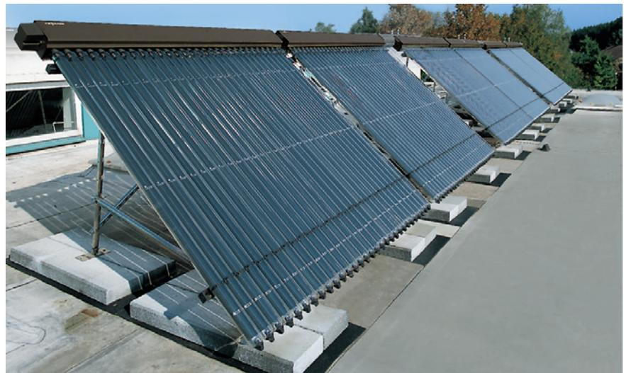
Feld aus Vakuumröhrenkollektoren, aufgeständert auf einem Flachdach
