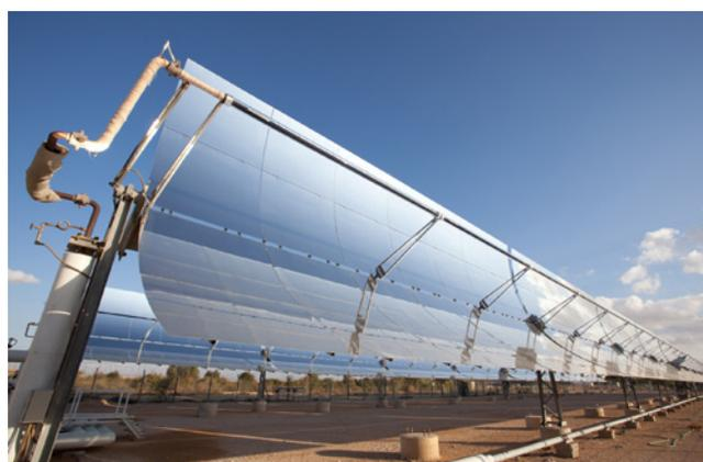
Kollektor eines Parabolrinnenkraftwerks
