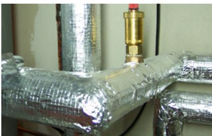
Das Dämmmaterial der Anschlussleitungen muss bis über 80° temperaturbeständig sein.
