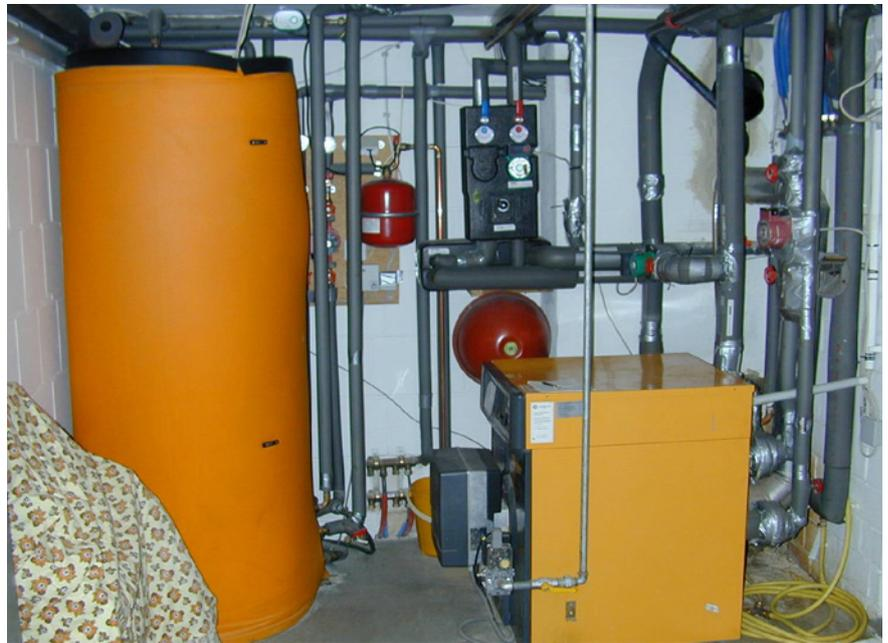
Geeigneter Aufstellungsort für den Speicher ist meist der Heizungskeller – der Anschluss des Heizkessels für die Nachheizung ist leicht möglich.
