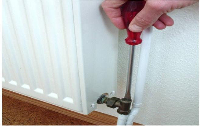
Die Einstellung der maximalen Durchflussmenge bei voll geöffnetem Heizkörperventil erfolgt durch eine einstellbare Drossel in der Rücklaufverschraubung. Alternativ können auch „Thermostatventile mit Voreinstellung“ eingebaut werden.
