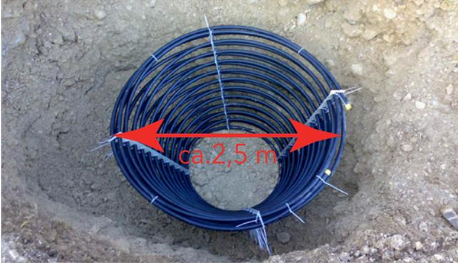
Für die Erdreichwärmepumpe im Niedrigenergiehaus werden zunehmend „Erdwärmekörbe“ verwendet. Dadurch lässt sich die Wärmequelle „Erde“ preisgünstiger erschließen, denn einen Bagger braucht man ohnehin auf der Baustelle. Die Entnahmelistung je Korb liegt je nach Untergrund und Größe des Korbes in einem Bereich von 0,7 bis 2,0 kW. [Foto: Firma BETATHERM]
