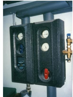
Pumpen und Armaturen sollten heute mit entsprechend geformten Hartschaumschalen gedämmt werden
