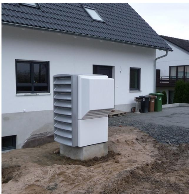
Luftwärmepumpen werden mit dem Argument beworben, dass sich mit ihnen die Kosten für eine Bohrung bzw. für das Eingraben eines Erdreichwärmetauschers sparen lassen. Der Preis dafür ist allerdings eine verringerte Effizienz
