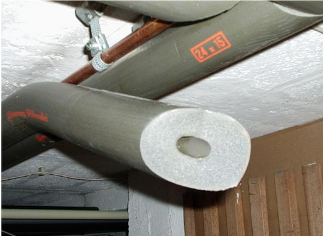
Ist die Dämmung der Heizleitungen im unbeheizten Bereich (z. B. Keller) etwa so stark wie der Rohrdurchmesser, ist die Heizanlagenverordnung erfüllt. Besser ist eine Dämmstärke, die sich am doppelten Rohrdurchmesser orientiert. Hier: 24mm Dämmung auf einem 15mm starken Rohr.
