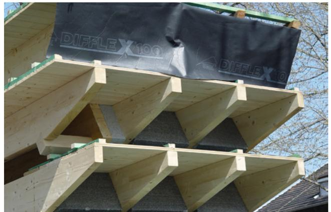
Durch die Verwendung von industriell vorgefertigten und komplett gedämmten Bauelementen, lassen sich auch bei hohen Dämmstärken die Kosten im Einzelfall sogar senken; hier: Dachelemente mit einer 35 cm dicken Dämmung aus Polystyrol zwischen den Sparren.
