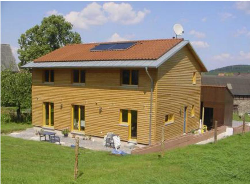
Die Erstellung von NEH in Holzbauweise hat den Vorteil, dass sich auch mit hohen Dämmstärken relativ schlanke Bauteile realisieren lassen. Werden industriell vorgefertigte Bauteile verwendet, sind Preise zu erreichen, die unter denen einer gemauerten Wand liegen können.
