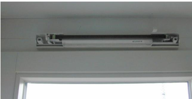
Feuchtgesteuerter Zulufteinlass über einem Fenster (Abdeckung entfernt)
