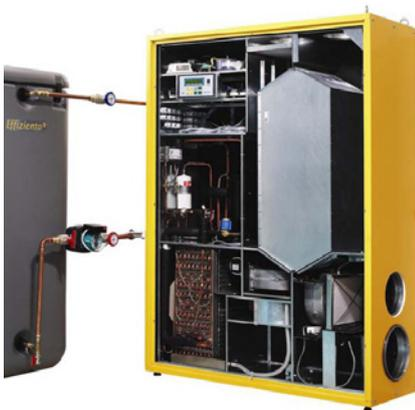
Ein Heizsystem für Passivhäuser: Das Kompaktaggregat. Eine Wärmepumpe gewinnt die Restwärme aus der Abluft des Lüftungswärmetauschers und nutzt sie für die Heizung der Zuluft und die Warmwasserbereitung.
