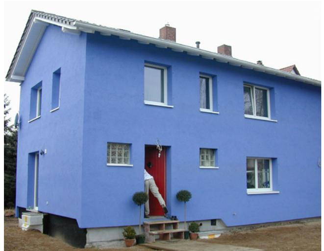
Dieses aus dem Jahr 1955 stammende Haus wurde im Rahmen einer umfassenden Sanierung auch mit einem 12cm dicken WDVS versehen. Zusammen mit der Erneuerung der Fenster, sowie der Dämmung von Dach und Kellerdecke hat sich der **Energieverbrauch um über 60% verringert**.
