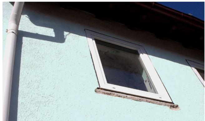
So ist die Fassade ideal für das Aufbringen der Dämmung vorbereitet: Die neuen Wärmeschutzfenster sind außenbündig eingebaut und die Kanten der alten Fensterbänke wurden abgestemmt.
