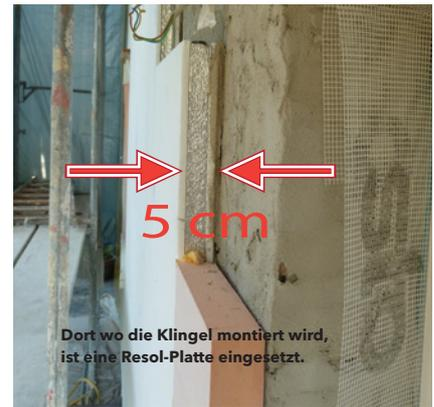
Bei einem Modellprojekt in Frankfurt wurden durch das Abschlagen des alten Putzes etwa 2 cm Tiefe gewonnen. Auch die Kosten für diesen zusätzlichen Aufwand hat das Amt für Denkmalpflege übernommen. Durch das schlanke Dämmsystem aus Vakuuminulationspaneelen wird nach dem Auftragen des neuen Putzes das gedämmte Gebäude nur etwa 4 cm an Wandstärke zulegen.
