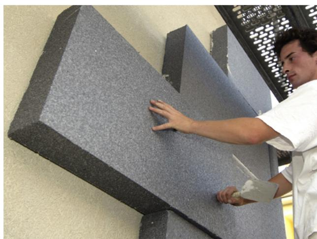
Hier wird eine 12 cm dicke Dämmschicht aus Polystyrol an der Wand eines Wohnhauses verklebt. Diesem Dämmstoff sind vom Hersteller kleine Mengen an Graphit zugegeben worden (daher die graue Farbe des sonst weißen Materials). Die Wärmedämmeigenschaften konnten dadurch, verglichen mit herkömmlichen Polystyrol, um 14 %, verbessert werden.
