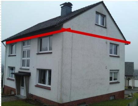
1) 20cm Zellulosedämmung
